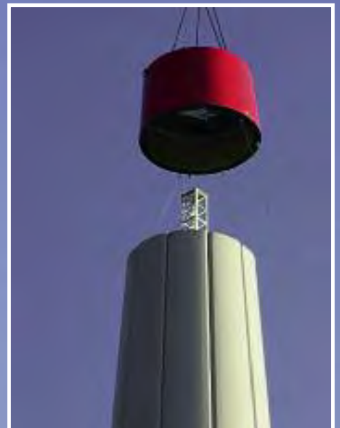
Der Konus wird aufgesetzt
