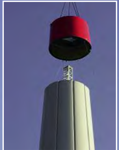
Der Konus wird aufgesetzt
